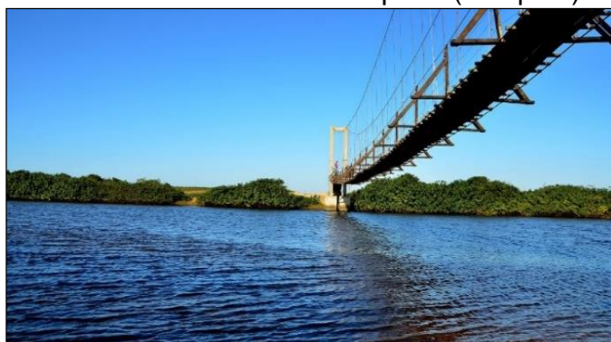
Figura 96 - Ponte Pênsil sobre a Barra do rio Itapocu (Araquari).
