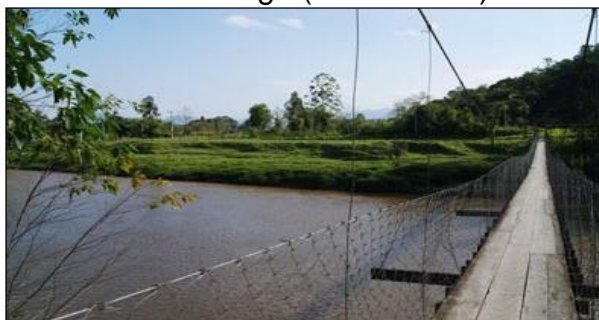
Figura 224 - Ponte Pênsil de Guaraminga (Guaramirim).
