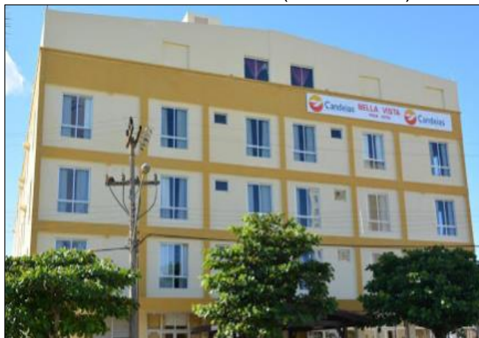
Figura 112 - Candeias Bela Vista Barra Velha (Barra Velha).
