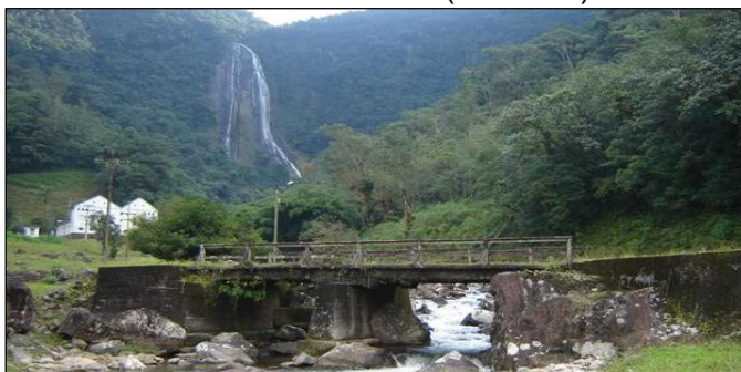
Figura 299 - Salto do Pirai - Usina Hidrelétrica (Joinville).
