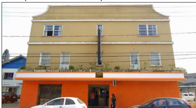
Figura 399 - Hotel Tank (São Bento do Sul).
