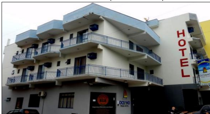
Figura 116 - Hotel Oceano de Barra Velha (Barra Velha).
