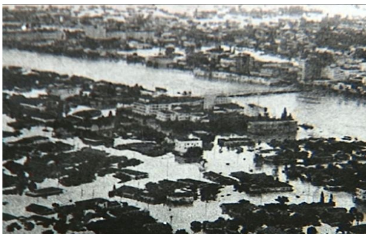
Enchente de 1974 em Tubarão
